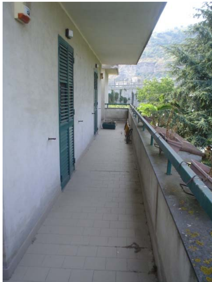
Balcone lato est
