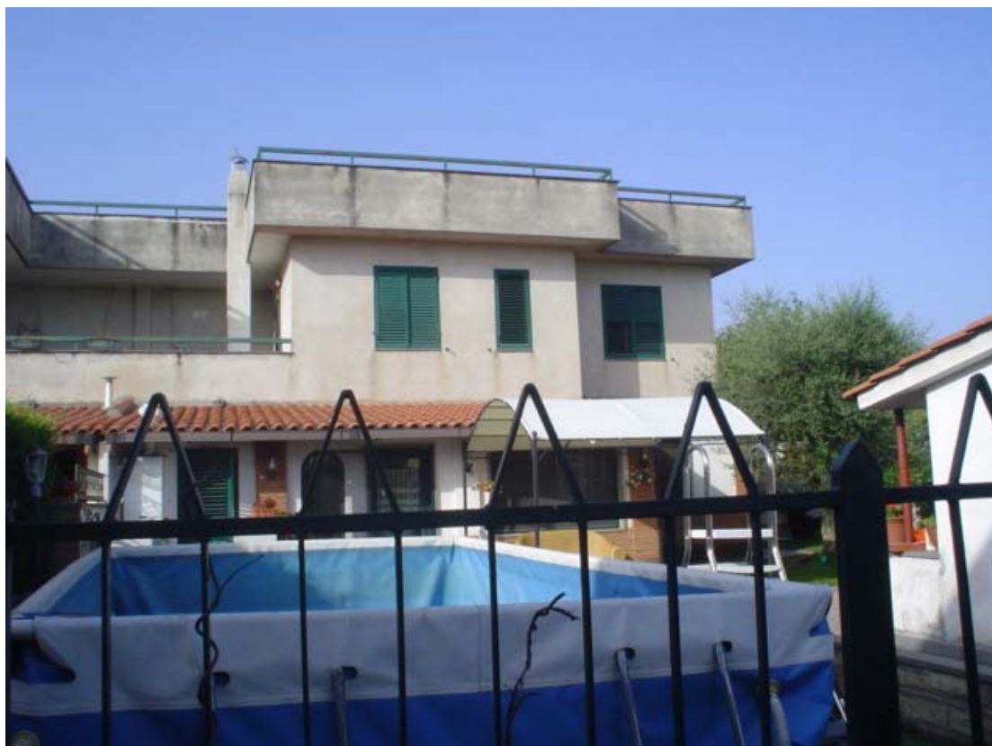
Vista dal lato ovest del lotto n° 1 con particolare di sistemazione esterna e balcone lato posteriore
