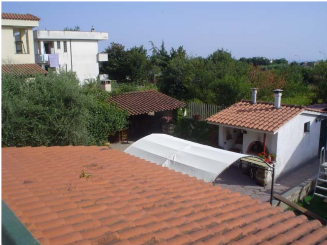
Tettoia coperta e capanno per gli attrezzi con forno a legna
