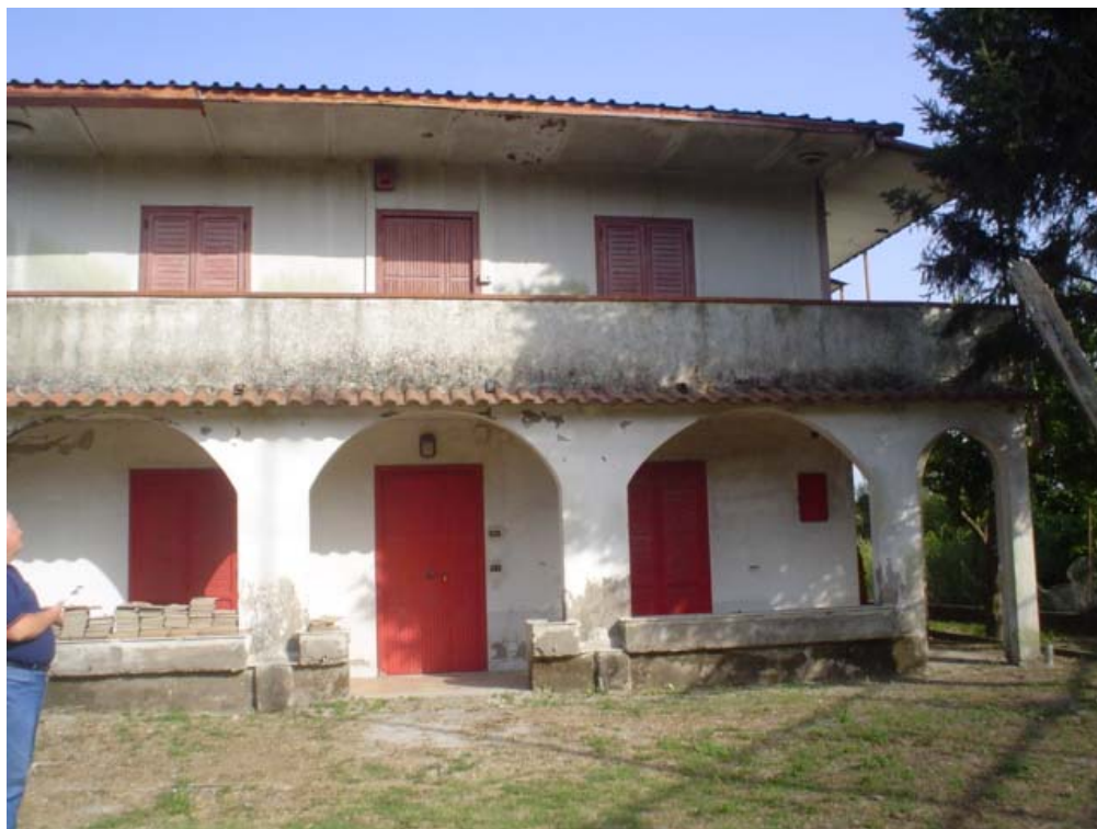
Facciata principale lato est con ingresso appartamento pignorato (al piano superiore)
