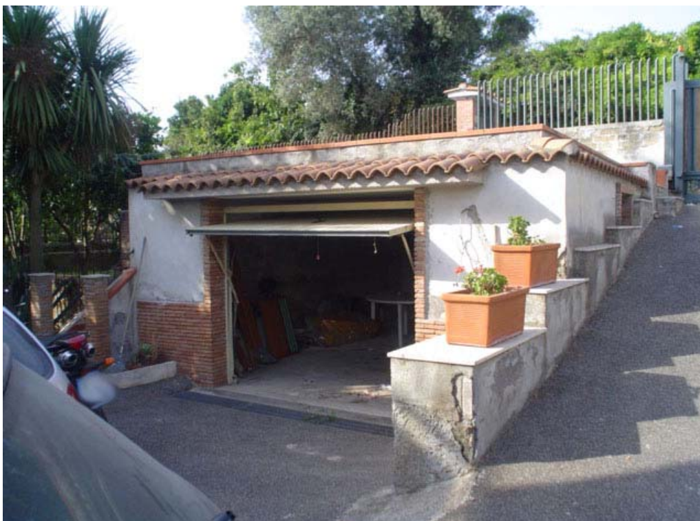
Garage pertinenziale al lotto 1)
