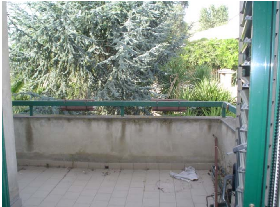
Balcone lato est
